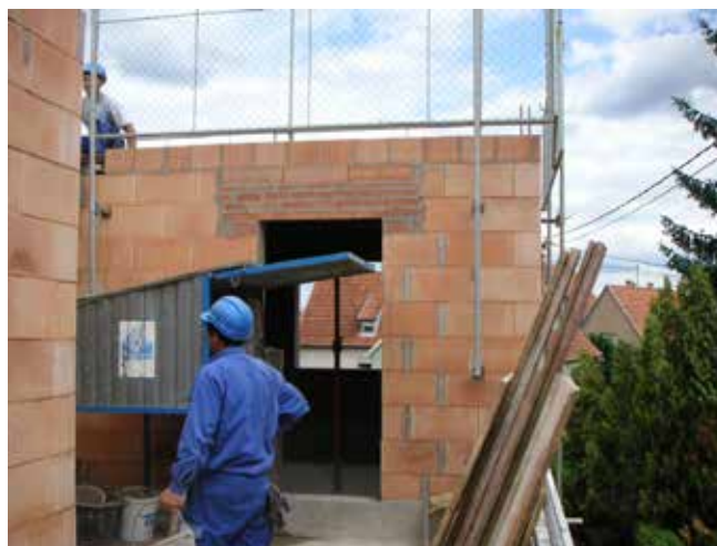
Protections fixées dans la maçonnerie
