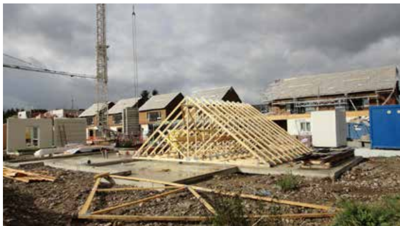
Assemblage total ou partiel au sol
