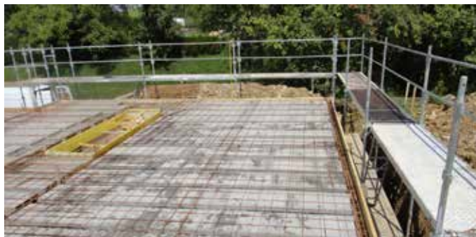
Protection collective par échafaudage de pied
