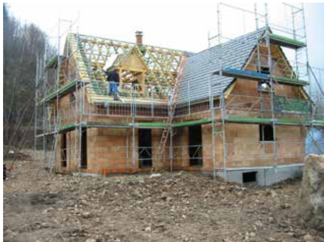
Echafaudage commun pour différents intervenants
